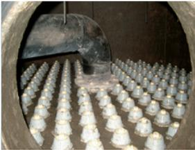
Neue Düsen wurden montiert
