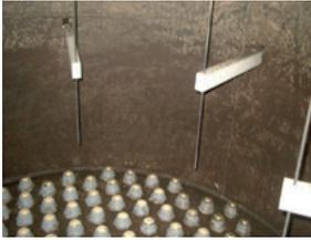
Anoden wurden montiert
