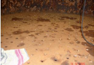
Düsenboden vor der Sanierung
