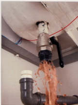
Redtrevet biofilm fra rørene passerer varmrørbeholderen og løber ud af håndventilen. Biofilm kan have mange forskellige former afhængt af forholdene – den kan også være farveløs.
