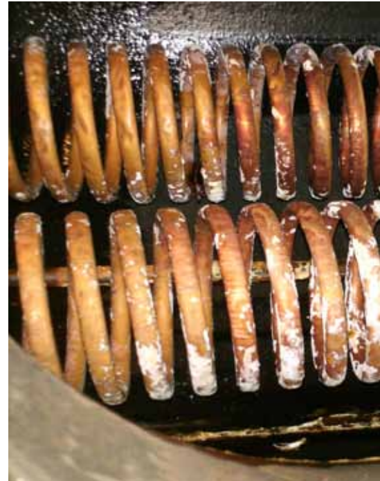
En varmtvandsbeholder før og efter en fysisk rensning. Det kunne have været undgået med et blødgøringsanlæg, mener VVS-installatør Kennet Jensen. Overslagsprisen for rensningen inklusiv ny anode beløber sig til 8.000 kr. Foto: R. Neubert & Søn A/S
