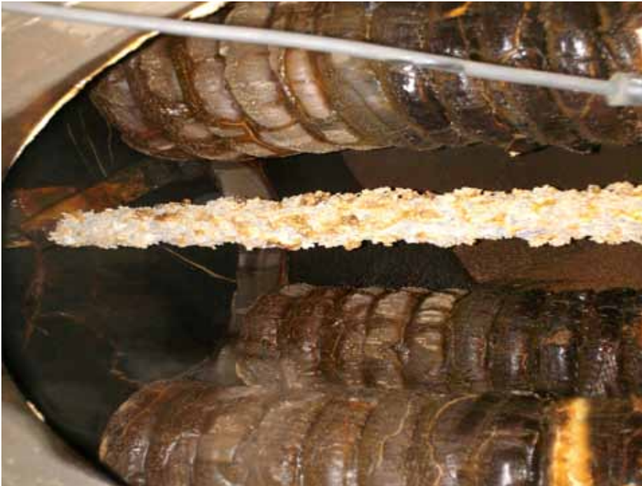
En varmtvandsbeholder før og efter en fysisk rensning. Det kunne have været undgået med et blødgøringsanlæg, mener VVS-installatør Kennet Jensen. Overslagsprisen for rensningen inklusiv ny anode beløber sig til 8.000 kr. Foto: R. Neubert & Søn A/S
